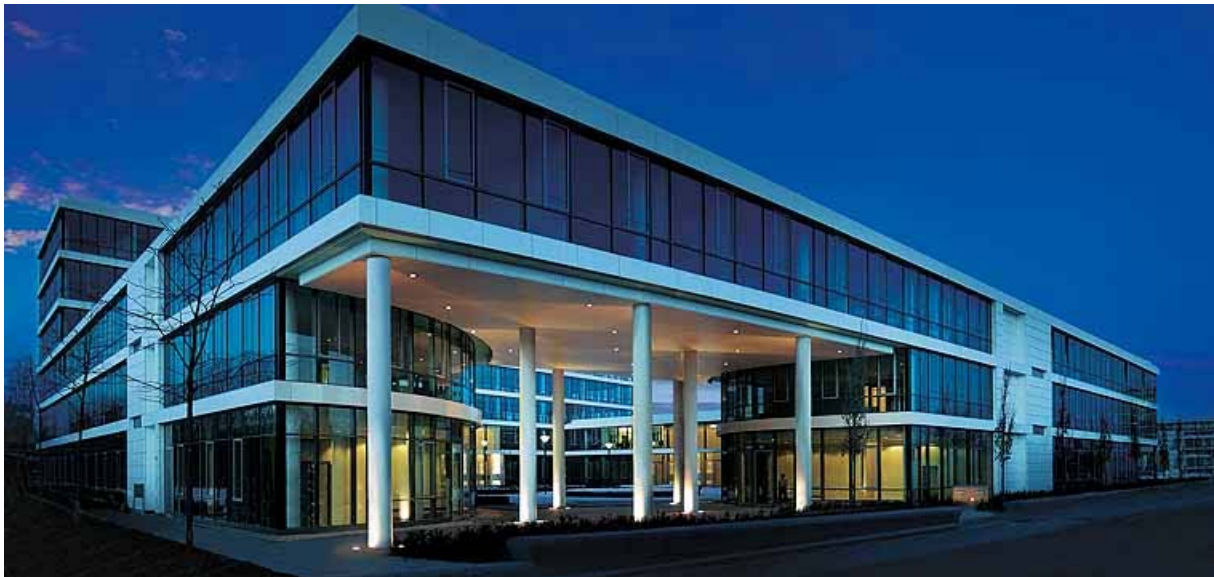
Bürogebäude CARREA, Wilhelm-Wagenfeld-Straße 16 – 24
